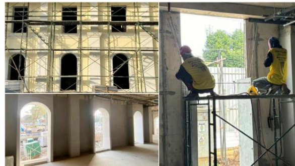
รูปแบบซุ้มหน้าต่าง และการติดตั้งจริง
