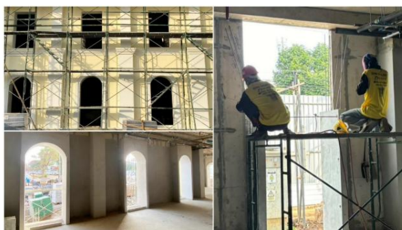
รูปที่ 1 รูปแบบซุ้มหน้าต่าง และการติดตั้งจริง
