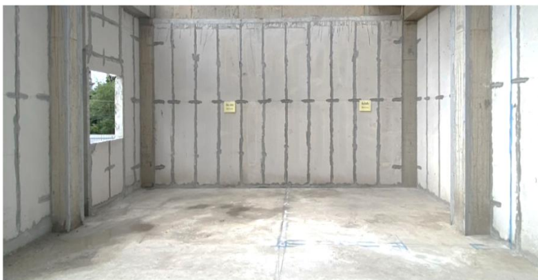
รูปที่ 3 การติดตั้งด้วยผนังคอนกรีตมวลเบาเสริมเหล็ก
