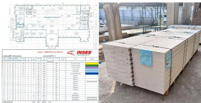
รูปที่ 1 การวางแผนการผลิตด้วย BIM และการขนส่งชิ้นงาน ตามตำแหน่งที่กำหนดในแบบ
