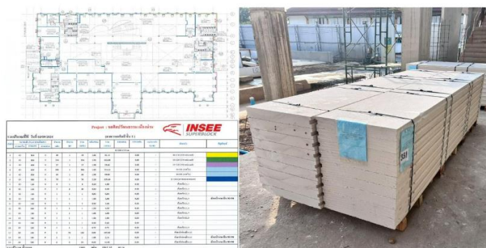
รูปการวางแผนการผลิตด้วย BIM และการขนส่งชิ้นงานตามตำแหน่งที่กำหนดในแบบ
