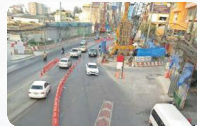
การติดตั้ง Barrier และป้ายเบี่ยงทิศทางการจราจร
