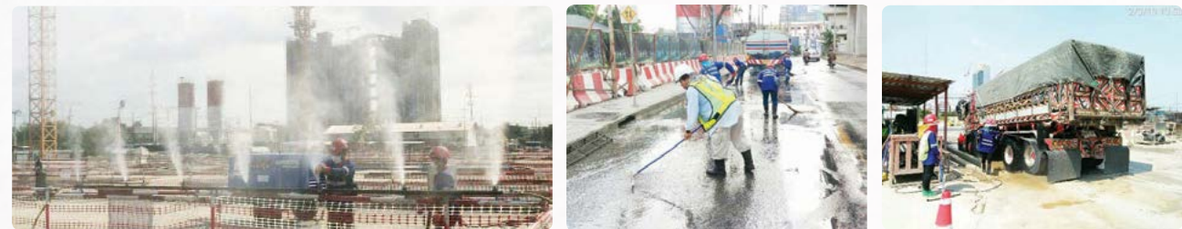
การพ่นละอองน้ำภายในพื้นที่งานก่อสร้าง และการทำความสะอาดถนนสาธารณะ
