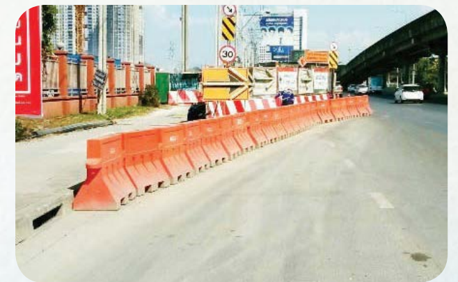
การติดตั้ง Barrier และป้ายเบี่ยงทิศทางการจราจร
