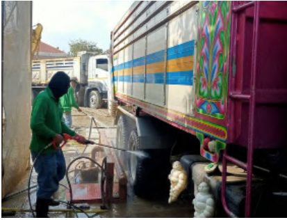
การจัดทำความสะอาดล้อรถ – การจัดผ้าไปปิดคลุมรถบรรทุกเศษวัสดุ และการทำความสะอาดถนนสาธารณะ ทางเข้า-ออกพื้นที่งานก่อสร้าง
