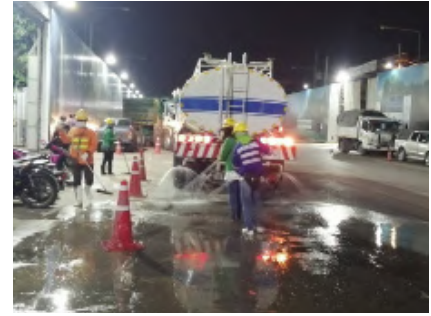
การจัดทำความสะอาดล้อรถ – การจัดผ้าไปปิดคลุมรถบรรทุกเศษวัสดุ และการทำความสะอาดถนนสาธารณะ ทางเข้า-ออกพื้นที่งานก่อสร้าง
