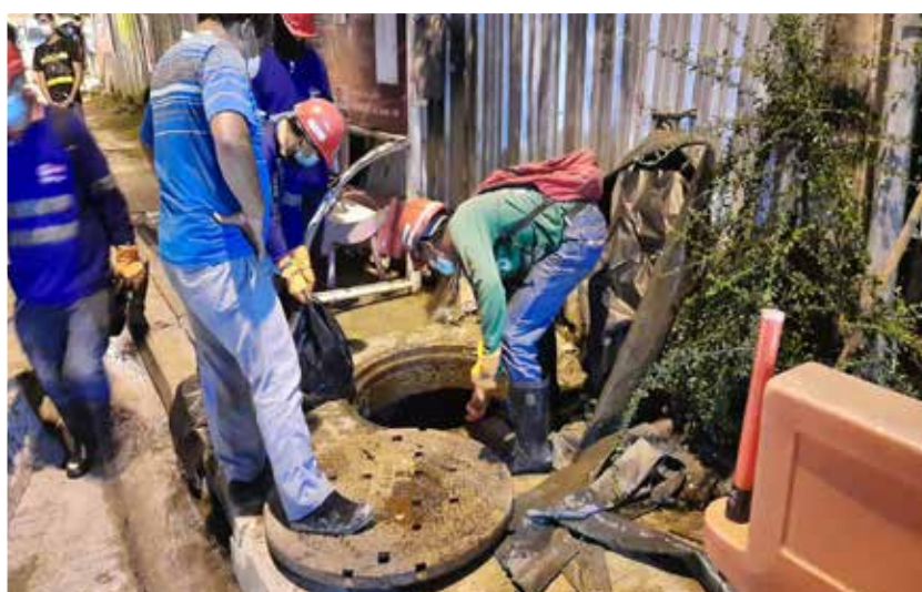
การเก็บตัวอย่างน้ำทิ้งจากระบบสุขาภิบาลที่ใช้ชั่วคราวระหว่างการก่อสร้างผ่านระบบน้ำเสียสำเร็จรูป
