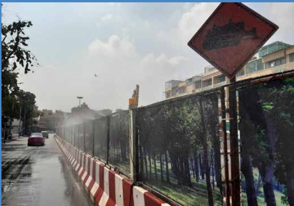
การจัดทำแนวรั้วที่รอบบริเวณพื้นที่โครงการก่อสร้าง
